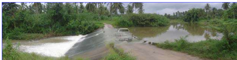
ฝ่ายทศบาลตำบลร่อนทองปัจจุบันใช้ทดน้ำในคลองทองเพื่อเป็นแหล่งน้ำต้นทุนให้กับหน่วยบริการร่อนทอง
